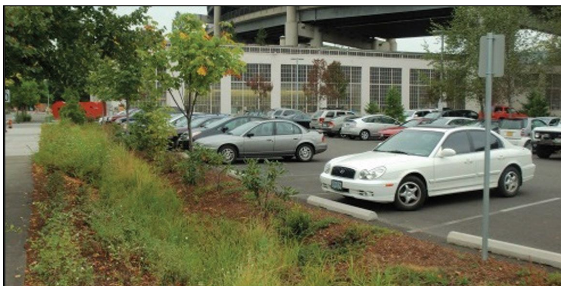
Figur 10. Exempel på infiltrationsstråk ansluten till parkeringsytor
